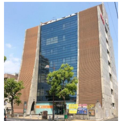
オルガホール外観
